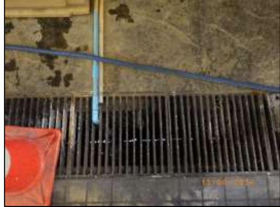
รูปที่ 2-17 ท่อรวมน้ำทิ้งในห้องพักมูลฝอยแต่ละประเภท
